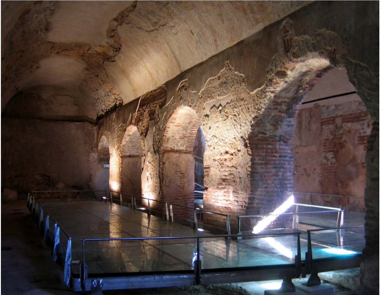
La cisterna del I secolo
